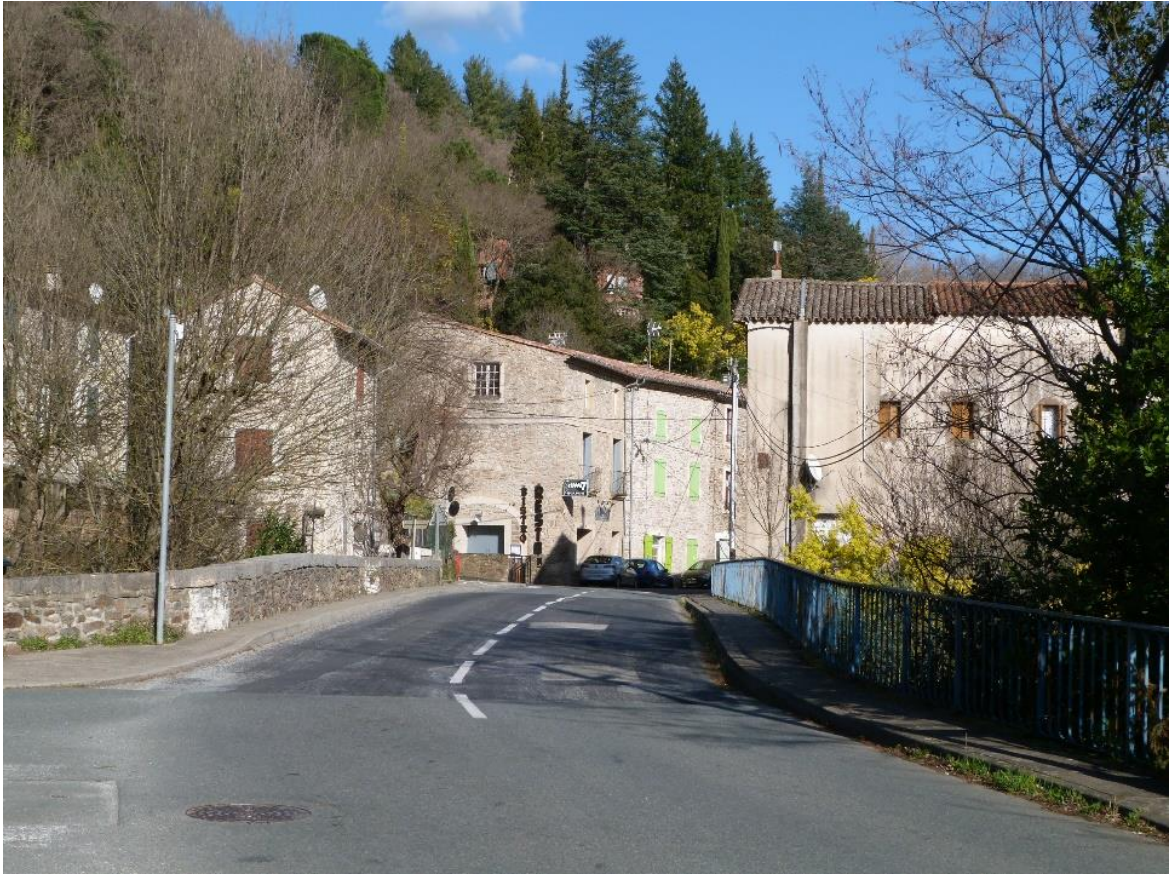
Vue actuelle : le changement le plus notable est, en 1977, la suppression du parapet maçonné de 1888 remplacé par une rambarde métallique. (cl. GB)
