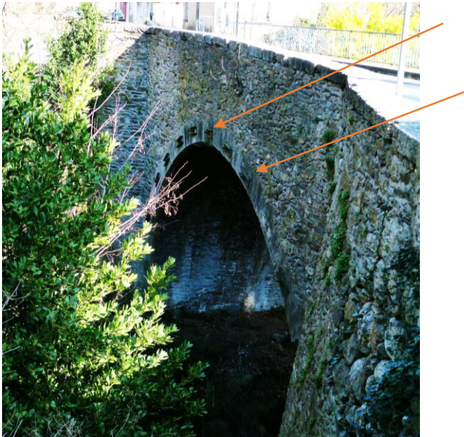
Afin de mieux maintenir le pont d'origine à son doublement, le pont a été doté de tirants au niveau des arcs frontaux. (Cl. GB)
