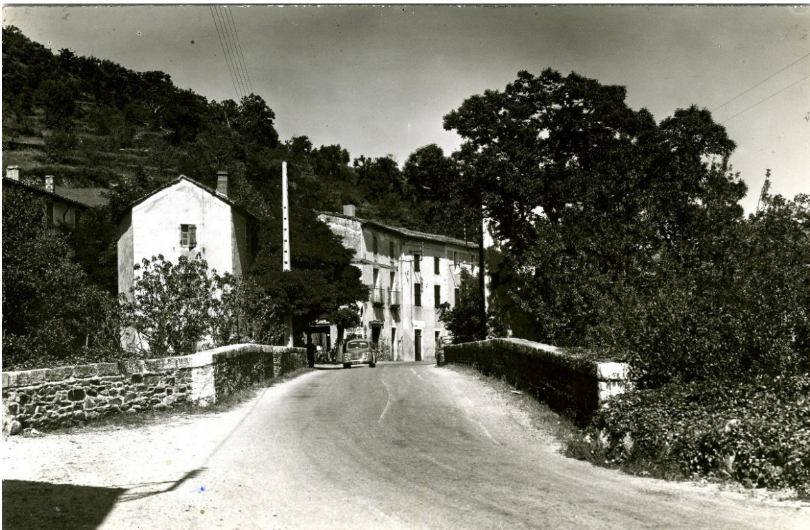
La chaussée du pont au milieu des années 1950. Il n'y a pas de trottoir. Le parapet de 1888 à droite est assorti au parapet de 1749 à gauche. (CPA, DR)
