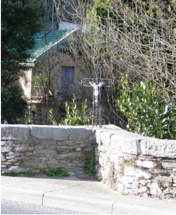
Croix du début du XXe siècle installée sur le parapet du refuge d'origine. Cette croix est adossée à la hampe d'une croix plus ancienne datant probablement de la construction du pont. (cl. GB)
